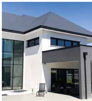
610 m 2 hus med golvvärme och VVS i Saint-Perst (Frankrike)
